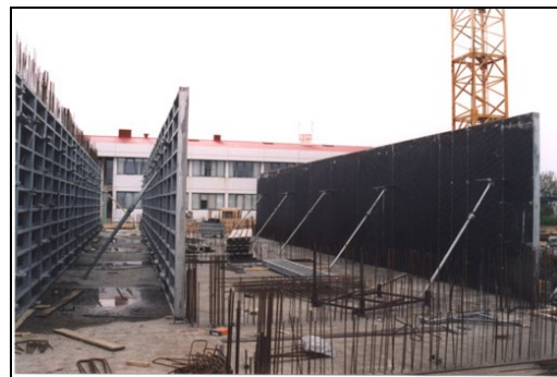
Unnið að uppsteypu HSU, Selfossi.
