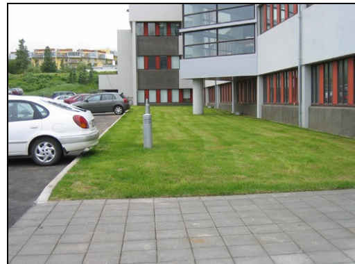
FSA Akureyri, bílastæði.
