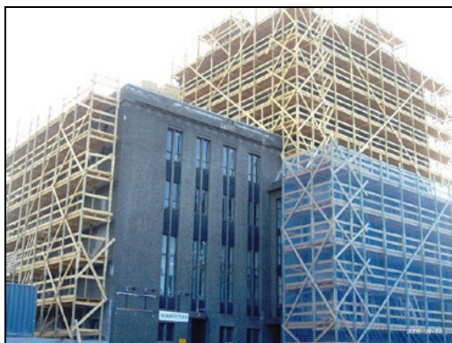
Verkpallar við Þjóðleikhúsið.
