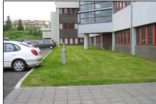
Frágengið bílastæði við suðurálmu FSA.
