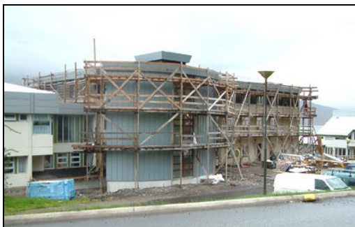
Fjórðungssjúkrahúsið á Neskaupstað, viðbygging í byggingu.
