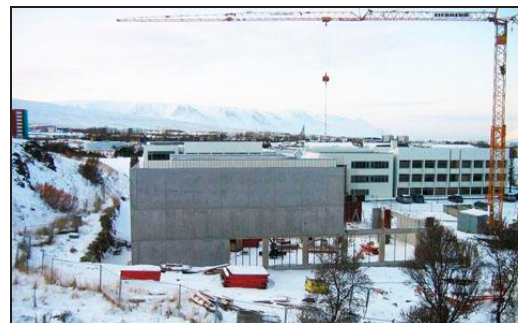
Kennslu- og fyrirlestrarými HA í uppsteypu.
