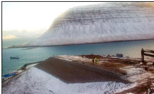
Varnargarðurur í Bíldudal í framkvæmd.
