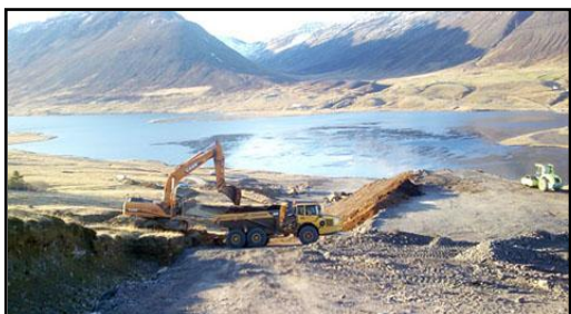
Snjóflóðavarnir í Ólafsfirði í framkvæmd.
