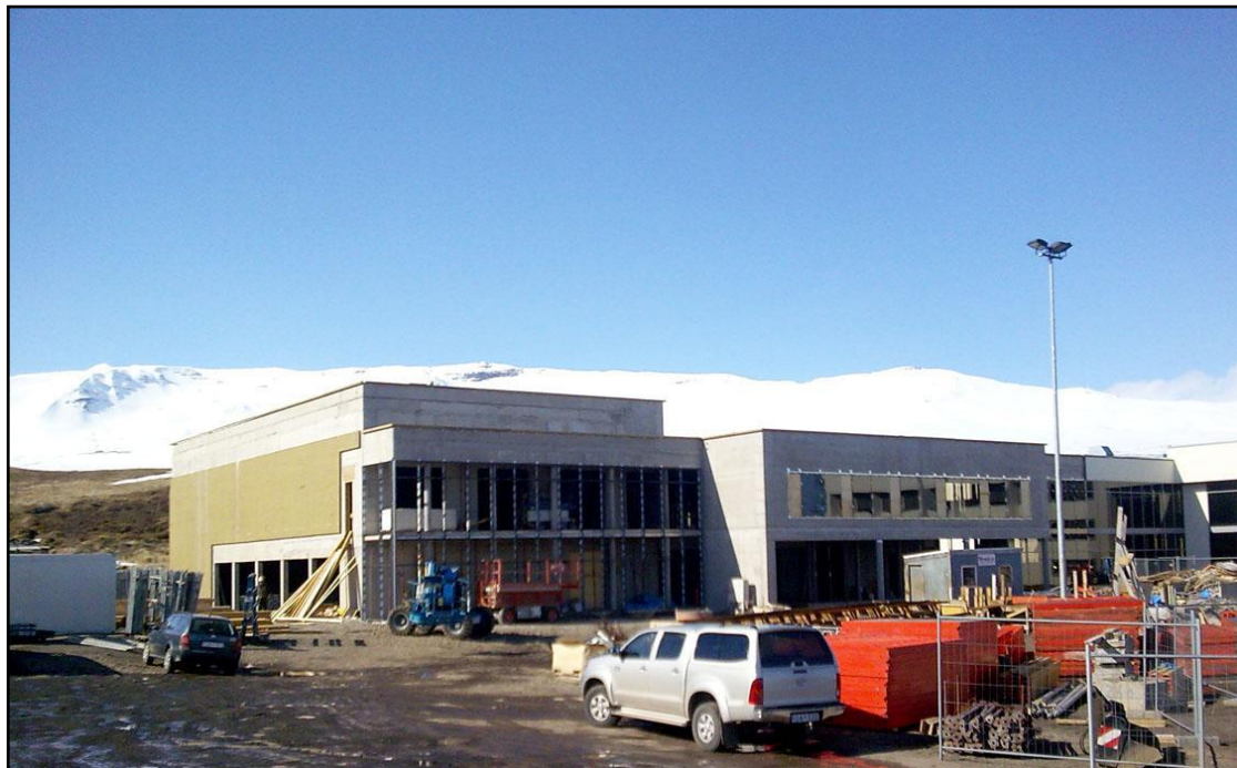
Kennslu- og fyrirlestrarými HA í byggingu.
