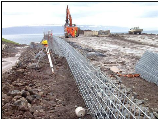
Framkvæmdir við varnargarð í Bolungarvík.
