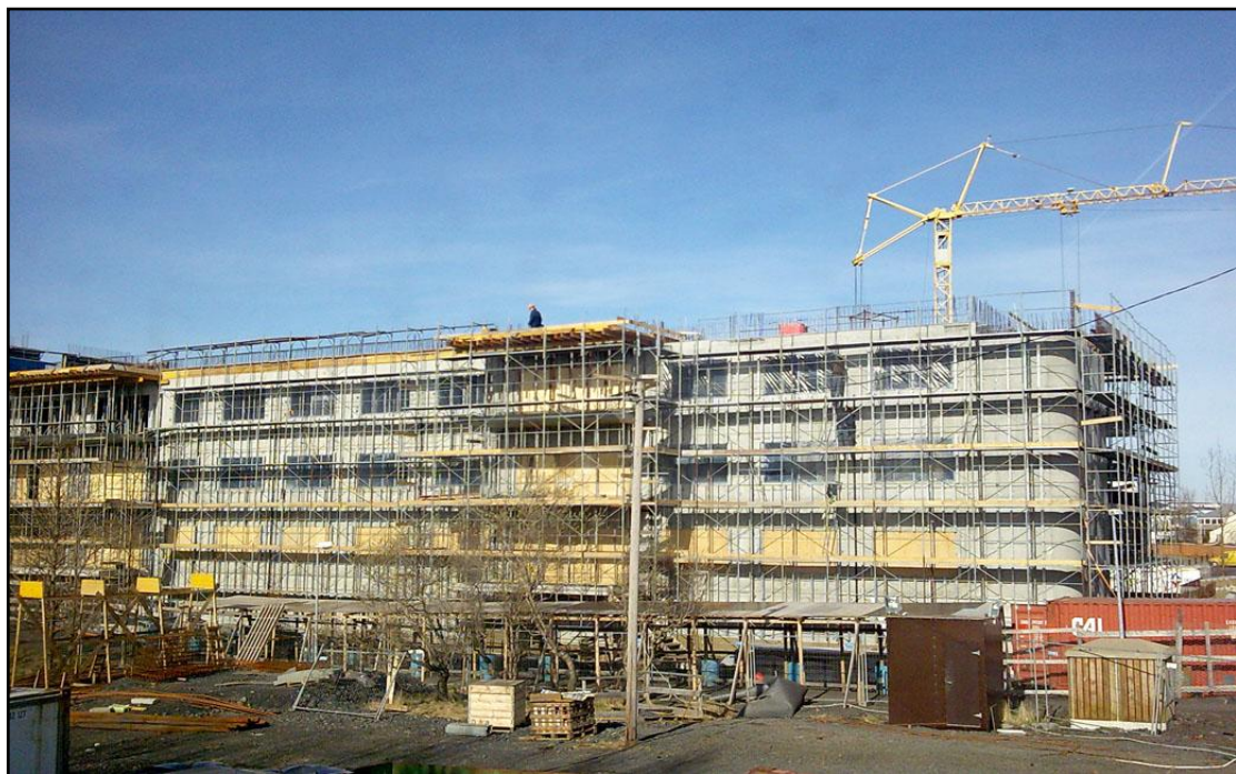
Hjúkrunarheimilið við Suðurlandsbraut 66 í byggingu.
