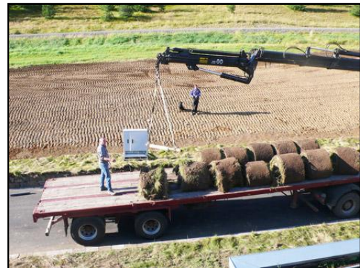
Unnið við lóðarfrágang við Snæfellsstofu.
