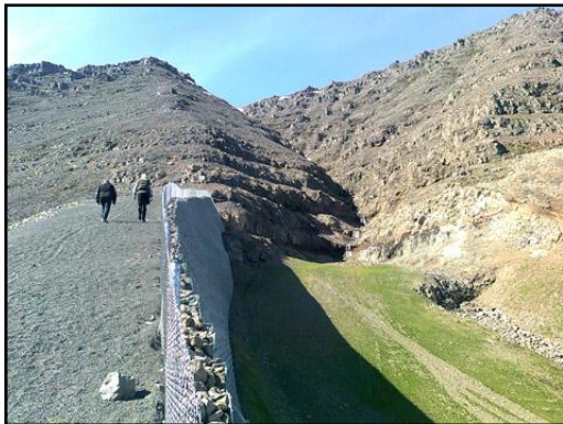
Snjóflóðavarnir í Bíldudal.
