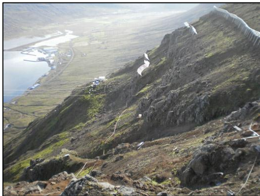
Snjóflóðavarnir á Neskaupstað, stoðvirki.
