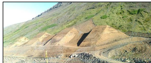
Snjóflóðavarnir í Bolungarvík.
