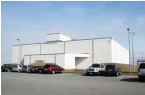
Bygging 130 á Keflavíkurflugvelli.
