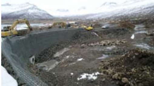
Framkvæmdir ofanflóðavarna í Fáskrúðsfirði.
