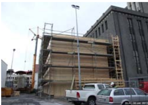
Viðbygging Þjóðleikhússins í byggingu.
