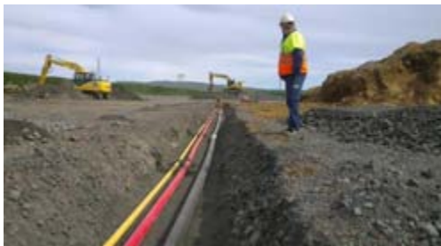
Fangelsið á Hólmsheiði. Unnið við jarðvinnu.
