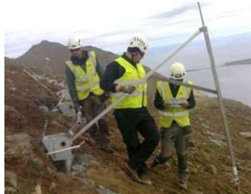
Unnið að uppsetningu stoðvirkja á Siglufirði.
