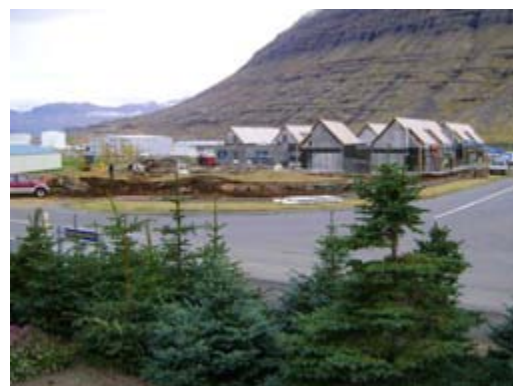
Hjúkrunarheimilið í Fjarðarbyggð í byggingu.
