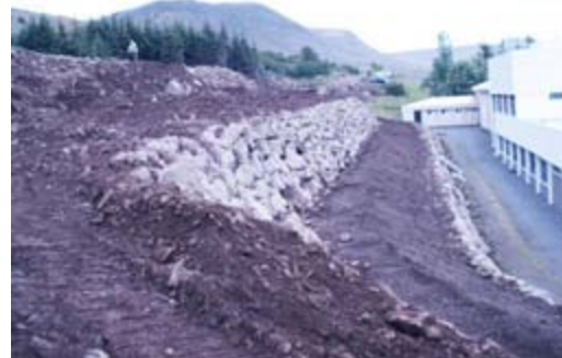
Snjóflóðavarnir Patreksfirði, þvergarður við Klif.
