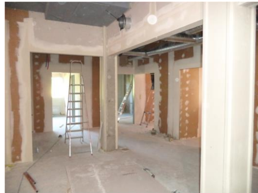
Uppsetning létttra veggja
