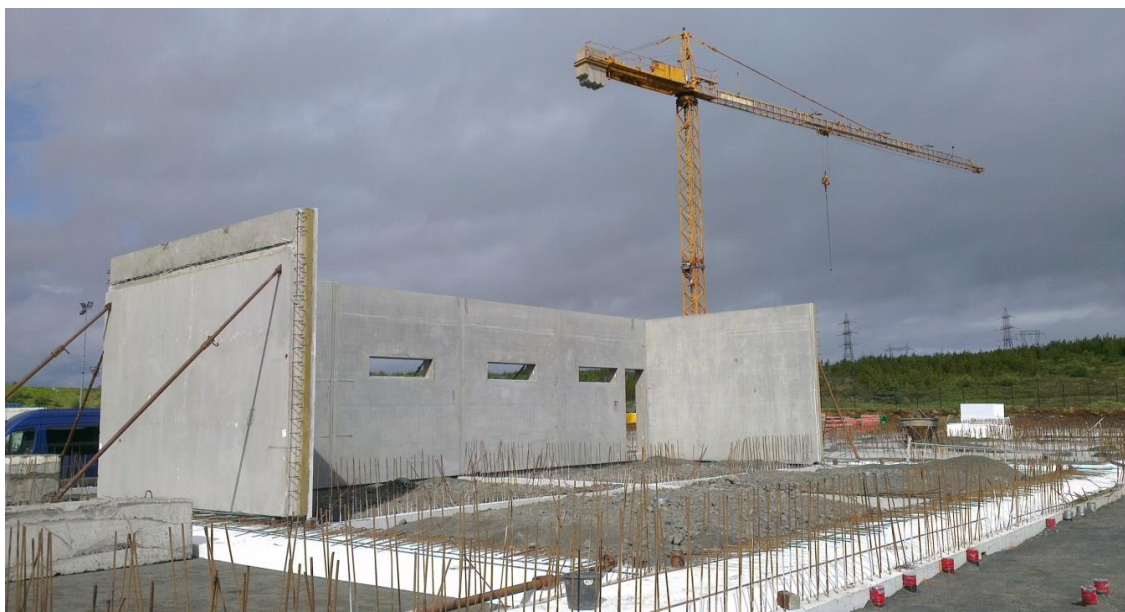
Forsteyptar veggeingar í Fangelsinu á Hólmsheiði
