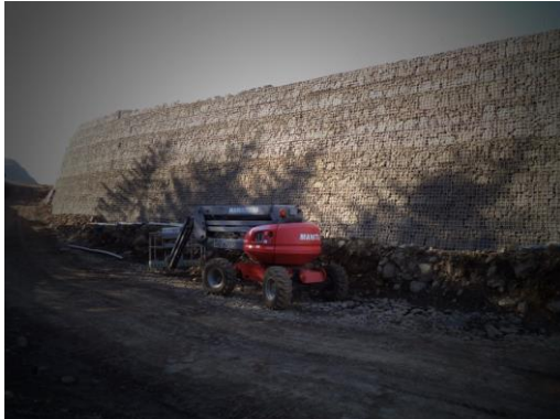
Snjóflóðavarnir Patreksfirði, þvergarður við Klif.
