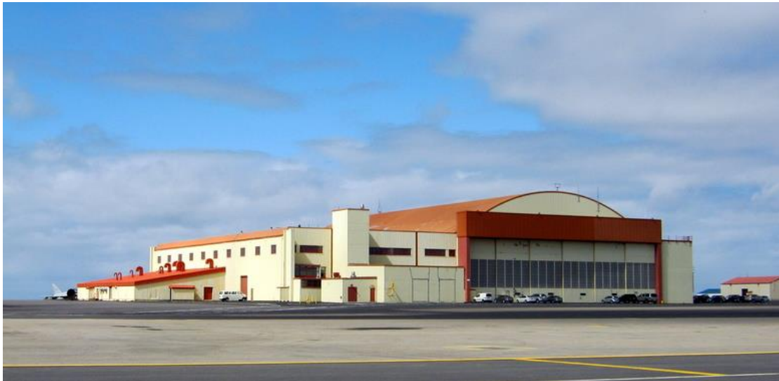
Bygging 831 á Keflavíkurflugvelli.
