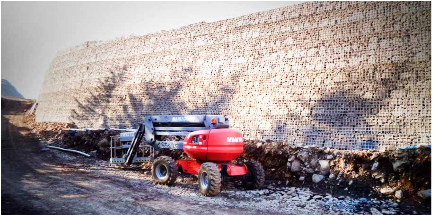
Snjóflóðavarnir Patreksfirði, þvergarður við Klif
