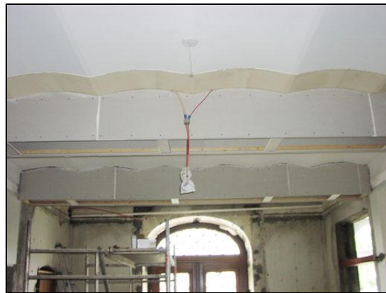
Viðgerð á bitum við lofthvelfingar.
