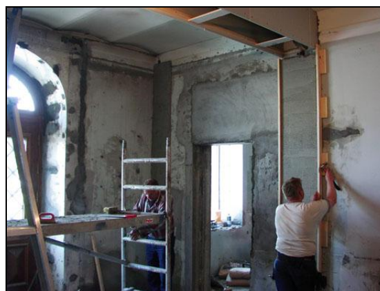
Unnið við múrverk.
