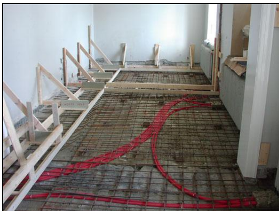
Gólf jámbent og tilbúið fyrir steypuvinnu.
