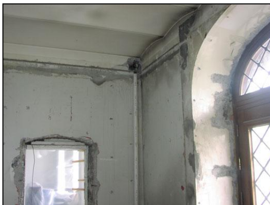
Lagfæringar á múr.
