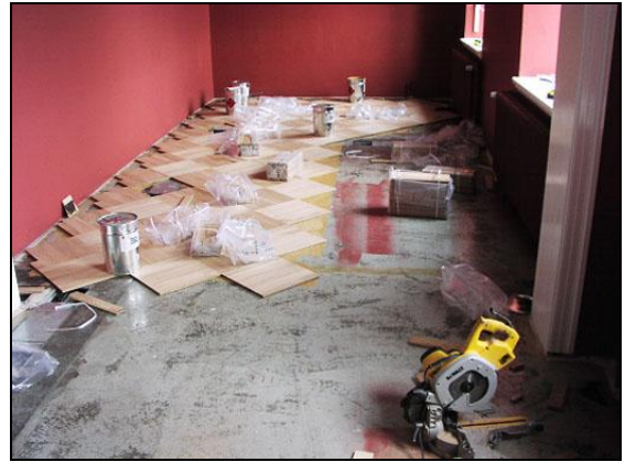
Unnið við parketlagningu á 1. hæð.
