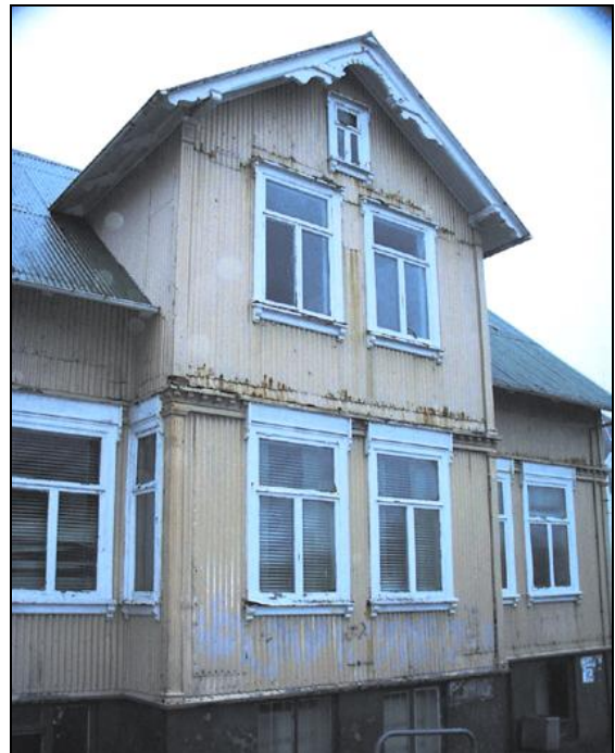
Norðurhlið fyrir viðgerðir
