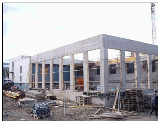
Veggir að fangagarði uppsteypdir.
