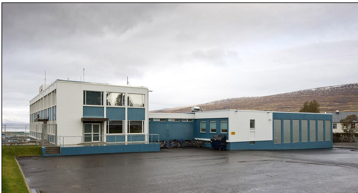
Afgirt malbikað plan sunnan við bygginguna.
