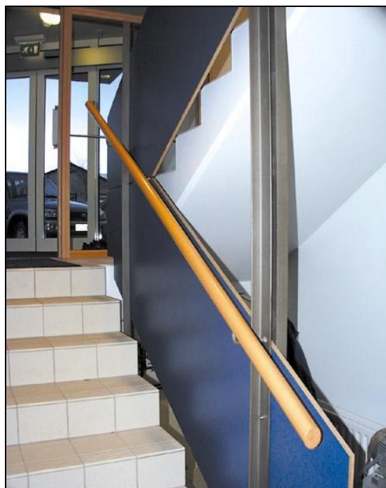
Handrið eftir lagfæringar
