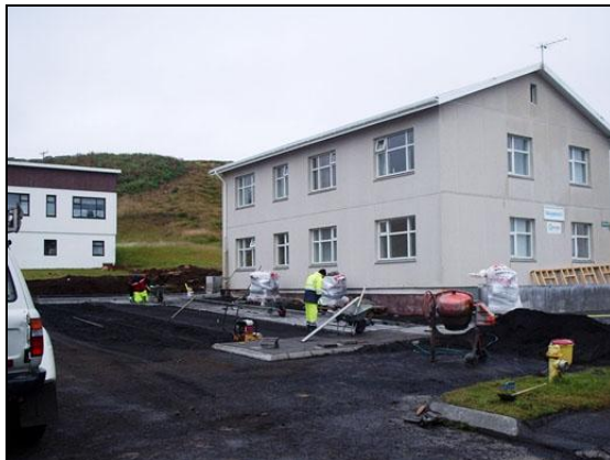
Framkvæmdir í september 2007.
