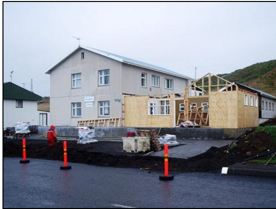
Framkvæmdir í september 2007.
