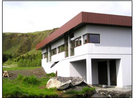
Ný viðbygging hjúkrunardeildar á Klaustri.
