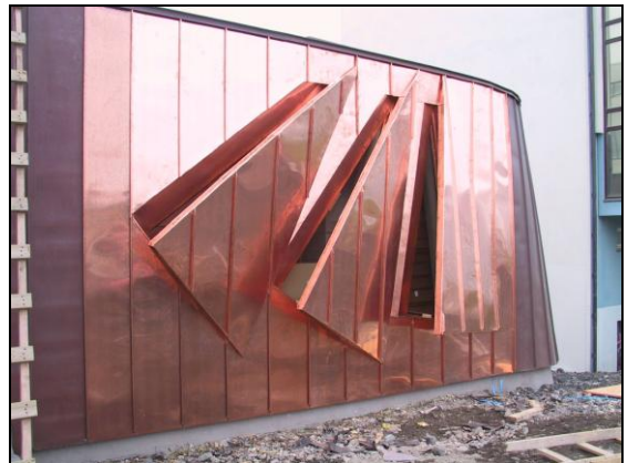
Koparklæðningu á útvegg lokið, í júlí 2002.
