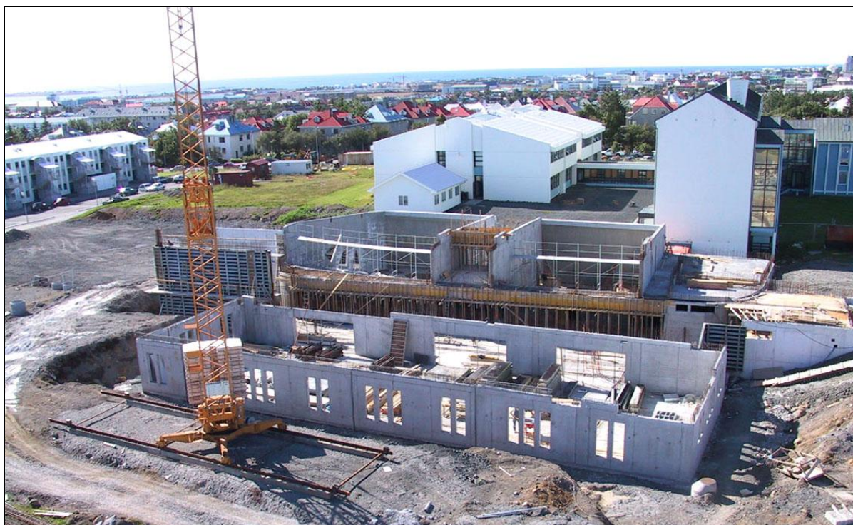
Veggir neðri hæða uppsteypdir, í maí 2001.
