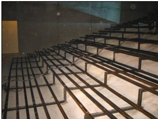
Grindur undir sætaröðum í fyrirlestrasal, í maí 2002.
