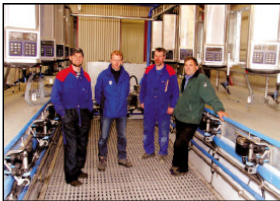
Í vel tækniþúnu fjósi. Ljós. Rafteikning hf.
