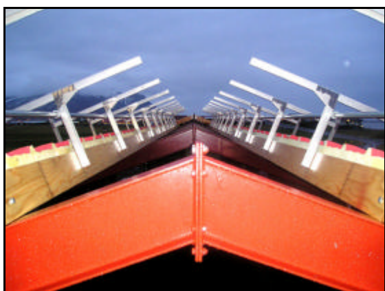
Stálsperur og frágangur í þakmæni. Mynd FSR.
