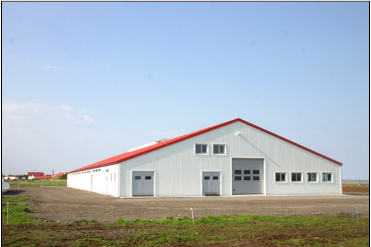
Kennslu- og rannsóknarfjós LBHÍ á Hvanneyri. Ljósm. Rafteikning hf. Í samræmi við hefð á Hvanneyri voru veggir hafðir hvítir og þak rautt.
