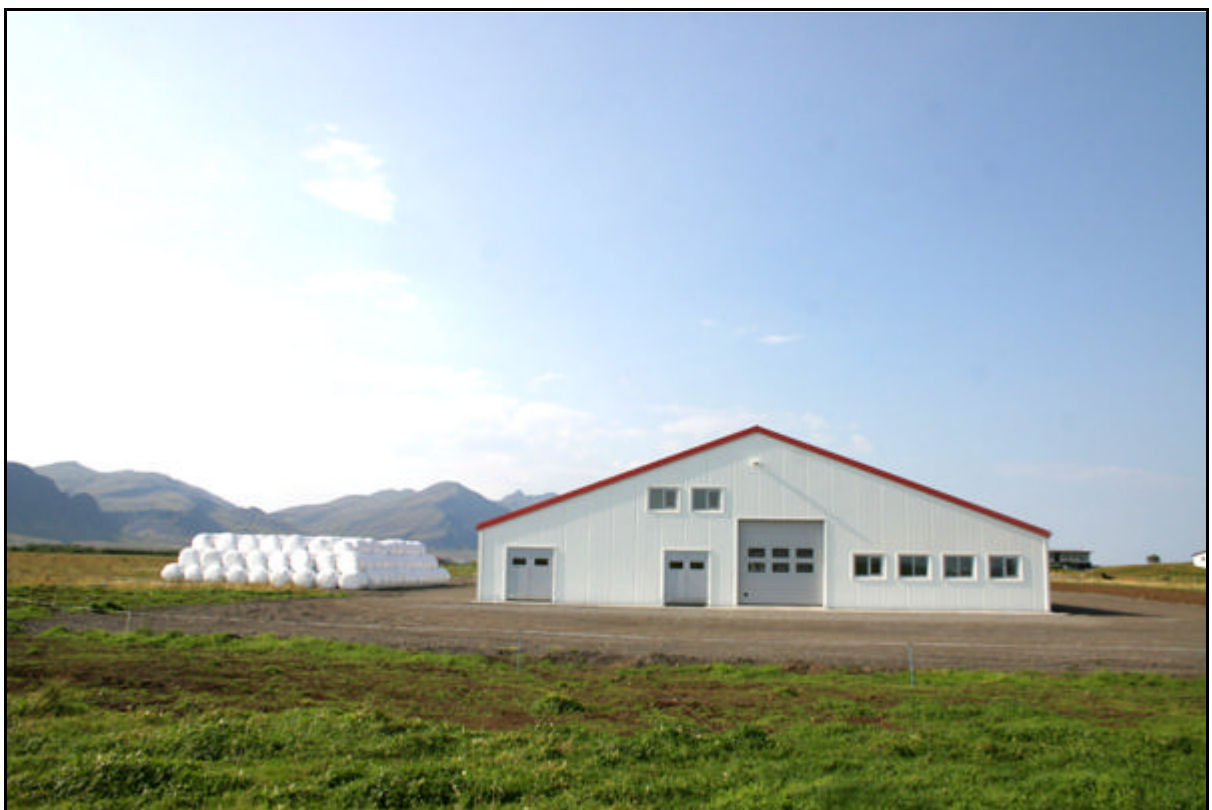
Kennslu- og rannsóknarfjós LBHÍ á Hvanneyri. Ljósm. Rafteikning hf. Aðkoma að fjósinu er á norðvesturgafli en aðföng dráttarvéla með heyfóður á suðaustlægum gafli.
