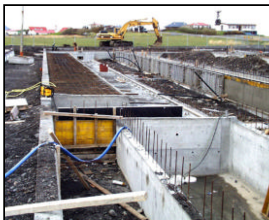
Fyllt í sökkla og svæði grófiöfnuð. Mynd FSR.
