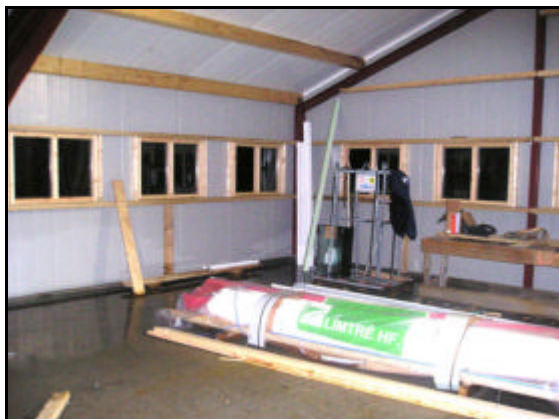
Við frágang hússins að innan. Mynd FSR.
