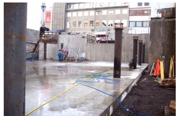
Burðarsúlur úr stáli fyrir efri hæð.
