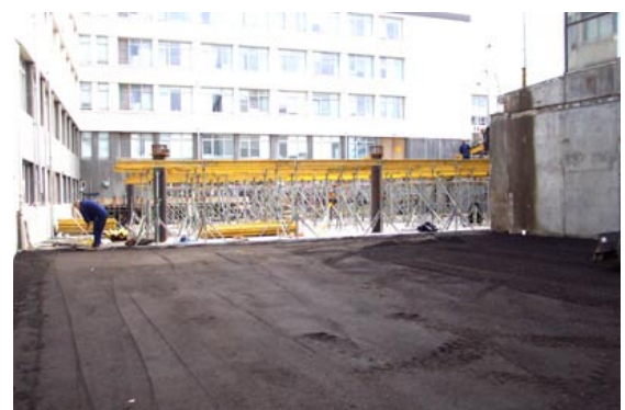
Undirsláttur efri plötu og jöfnun lóðar.
