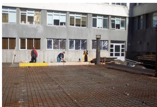
Járnabending neðri plötu
