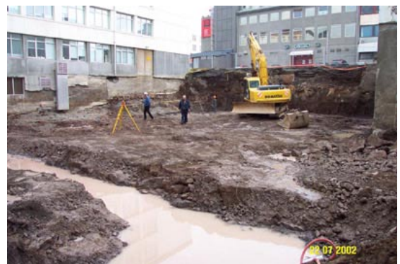
Lagnaskurður vegna nýlagna frá bílastæðahúsi.
