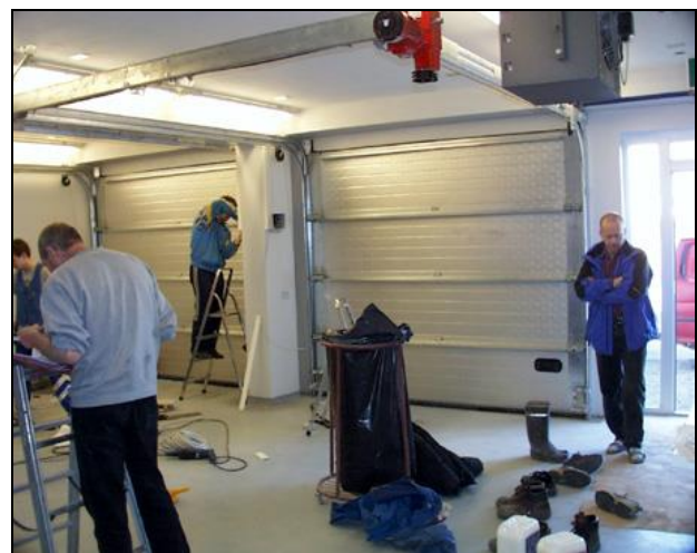
Lokafrágangur í bílgeymslu
