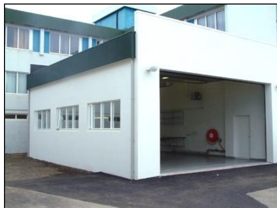
Bílgeymslan, byggð og fullbúin.
