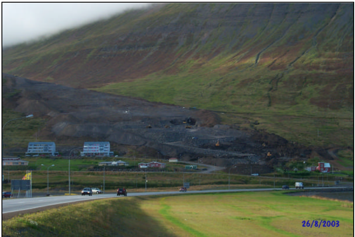
Framkvæmdasvæðið í ágúst 2003. Lokið var þá við að hreinsa laust efni af svæðinu.
