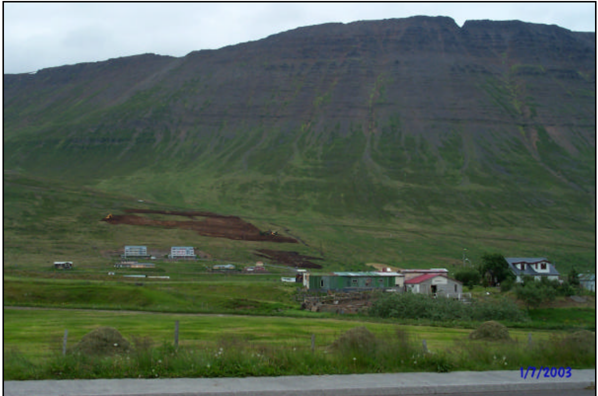
Framkvæmdir á byrjunarstigi.
