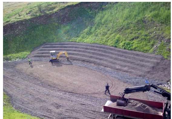
Mynd 13: Unnið við frágang á Ríplabás
