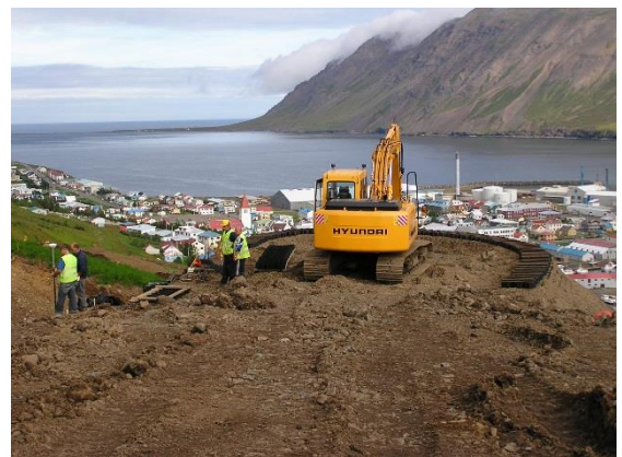
Mynd 6: Unnið við útsýnishaus
