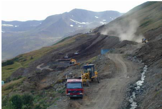
Mynd 8: Unnið í skeringu garðs 4
