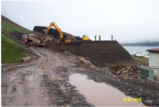
Mynd 7: Unnið við syðri haus á garði 5
