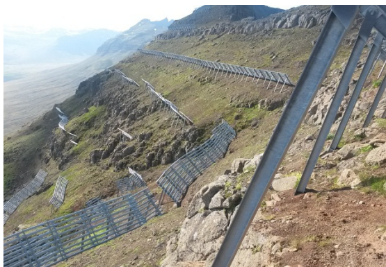
Mynd 8: Uppsett stoðvirki
