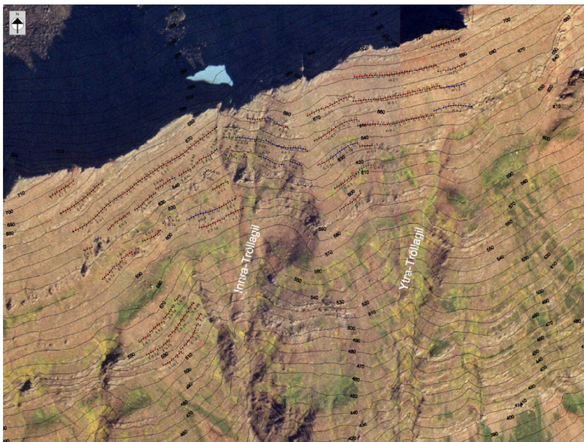
Mynd 9: Uppsett stoðvirki
