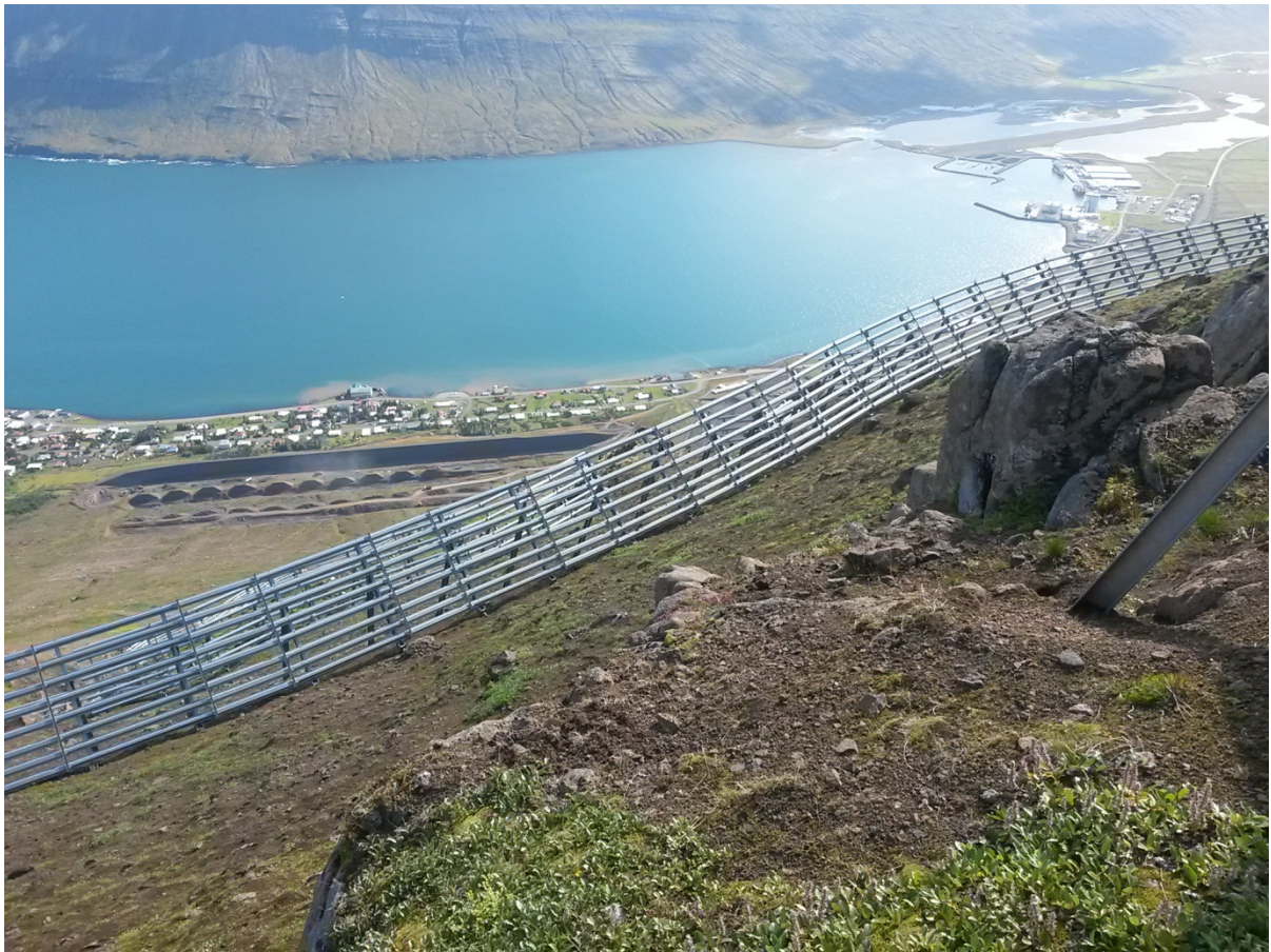
Mynd 6: Horft yfir bæinn og stoðvirkin, þvergarðar í baksýn
