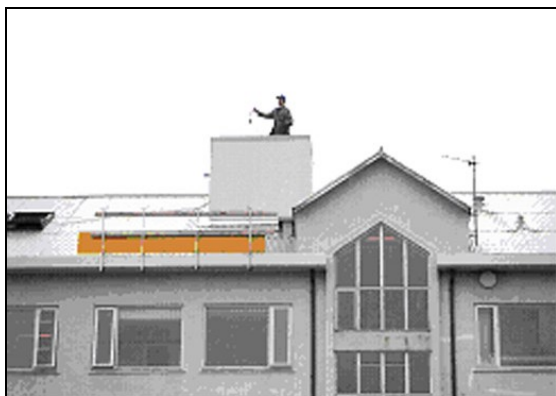
Lyftustokkur upp úr þaki hússins.
