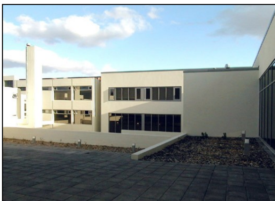
Inngarður, horft á skrifstofubyggingar A og A1.
