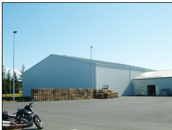
Nýtt vöruhús og tengibygging.
