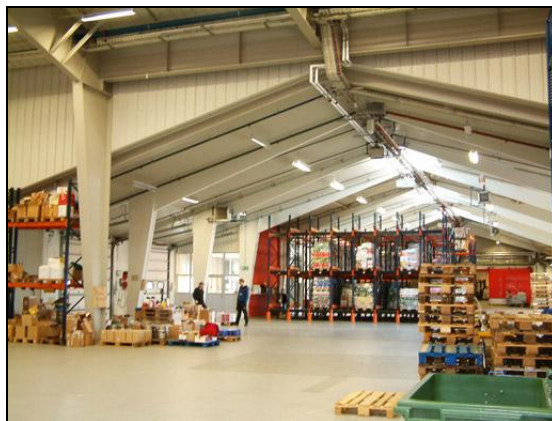
Vöruhús og tengibygging í ágúst 2011.
