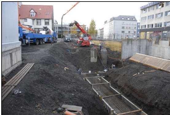
Lagnastokkur í húsgrunni.
