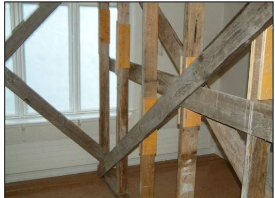
Stífingar inni til styrkingar fyrir flutning hússins.
