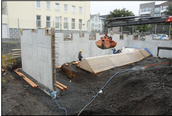
Sökkjar uppsteyptir, komið fyrir fyllingu.
