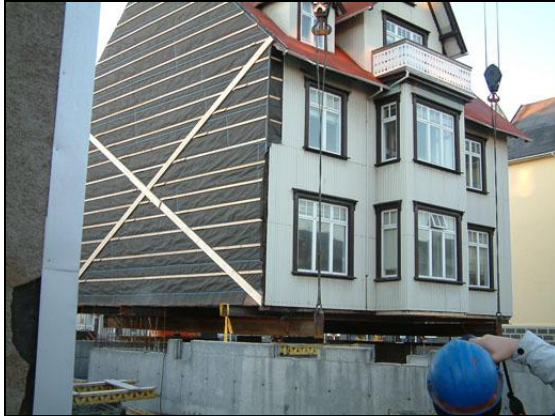
Húsið sett á nýja sökkl.
