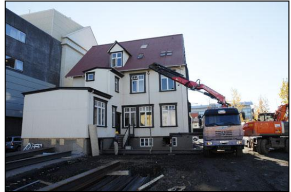
Undirbúinn flutningur viðbyggingar.
