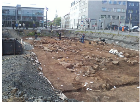
Mynd 2: Uppgraftarsvæði, horft til suðurs í átt að Vonarstræti og Ráðhúsi Reykjavíkur. Tjarnargata til hægri.
