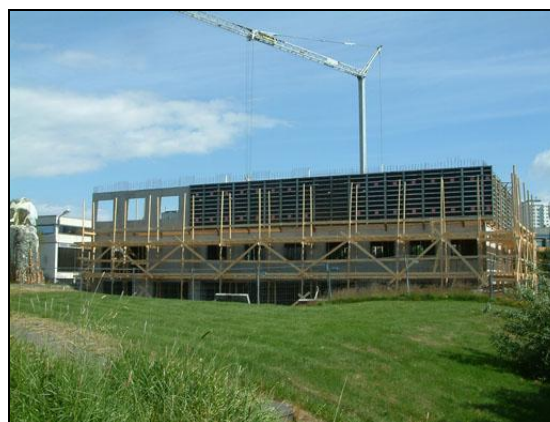
Á verktíma: Unnið við frágang utanhúss.
