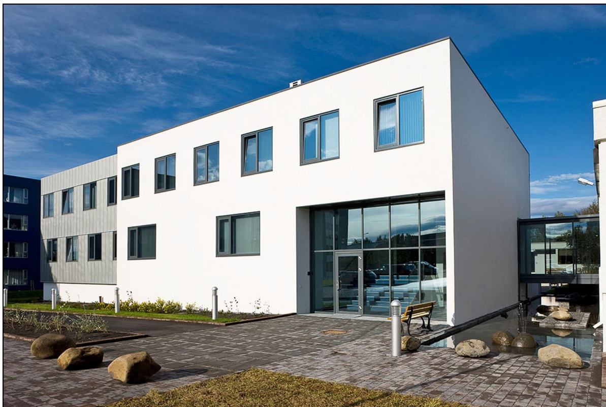
Fullfrágengin bygging og lóð.
