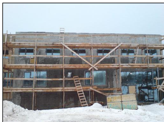
Á verktíma: Byggingin uppsteypst.
