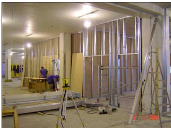
Unnið að uppsetningu gifsveggja.
