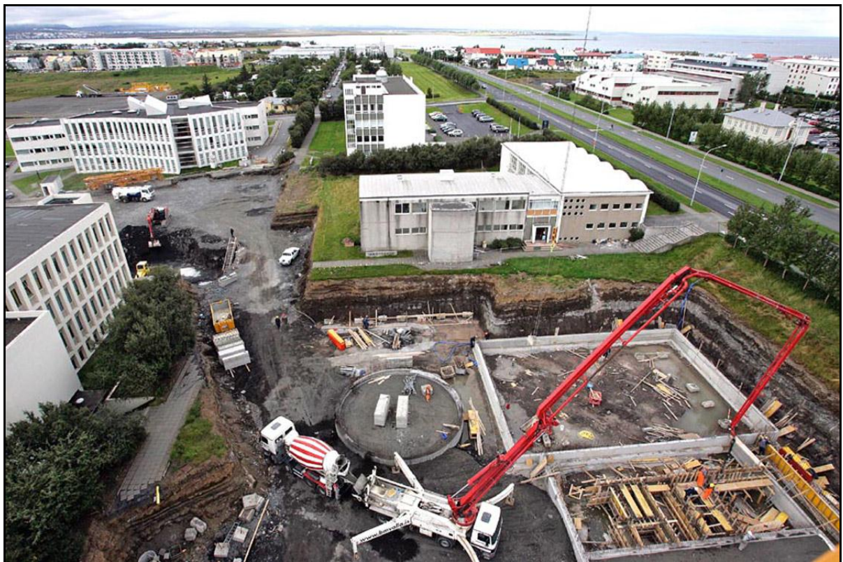
Sökklar Háskólatorgs að rísa. Byggingar Háskólans frá vinstri, Lögberg, Oddi, Árnagarður og Íþróttahús HÍ.
