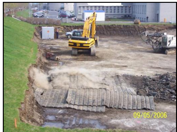
Sprengingar í grunni.
