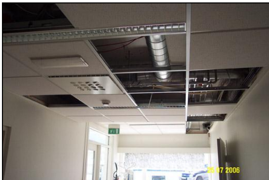
Niðurhengt loft í uppsetningu.
