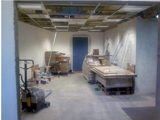
Mynd 12: Uppsetning loftaklæðninga
