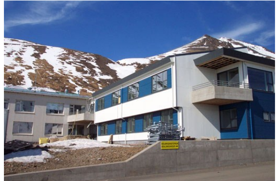
Mynd 1: Heilbrigðisstofnunin Siglufirði, viðbygging
