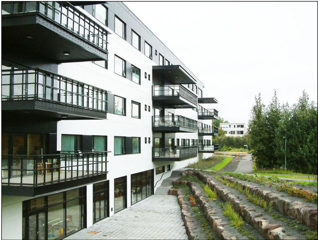
Hjúrkunarheimilið Mörk, suðausturhlíð byggingarinnar og lóðarfrágangur.
