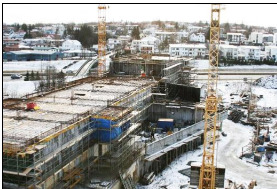
Unnið að uppsteypu.
