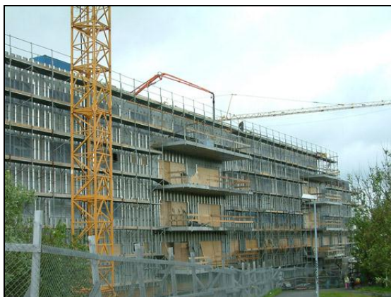
Komið leiðarakerfi fyrir utanhússklæðningu.
