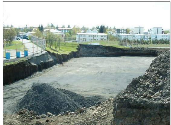
Fylling komin í grunn.
