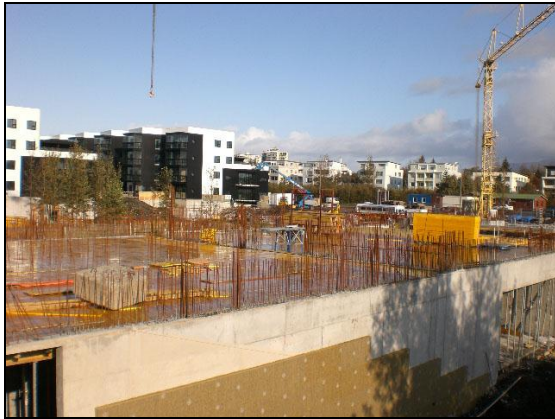
Uppsteiptir sökkjar og botnplata.
