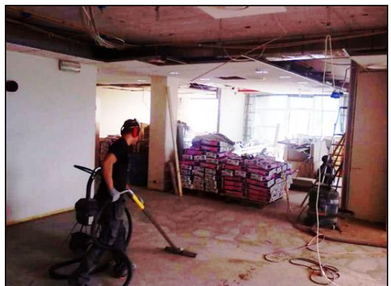
Sölvhólsgrata 7. Unnið við gólf.
