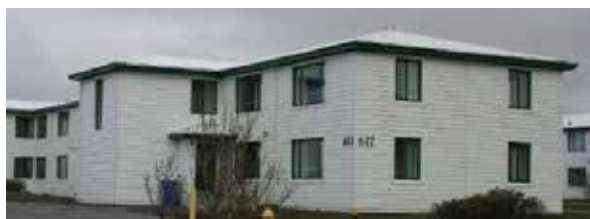
Mynd 7. Bygging nr. 617, gistihús, íbúðahús, 7 íbúðir.
