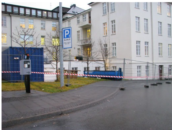
Mynd 6: Framkvæmdasvæðið við upphaf verks
