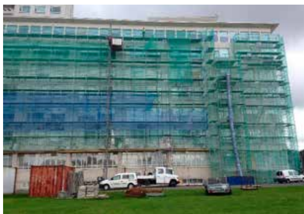
Mynd 12. Skipt um glugga, endursteinging suðurhluta A-álmú.
