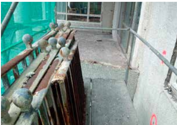
Mynd 9. Eldri handrið fjarlægð og ný eins handrið smíðuð.
