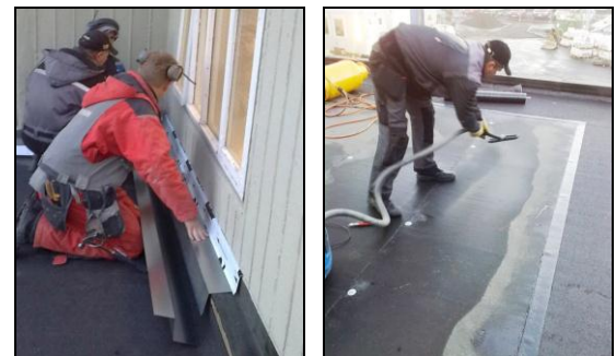
Unnið að þakfrágangi.
