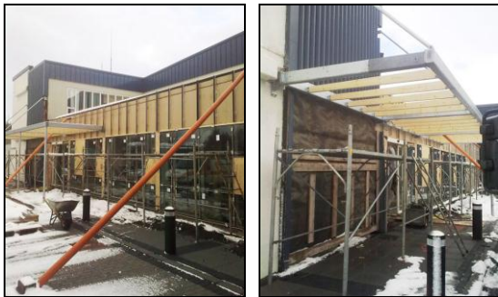
Unnið að útveggjaklæðningu og skyggni.
