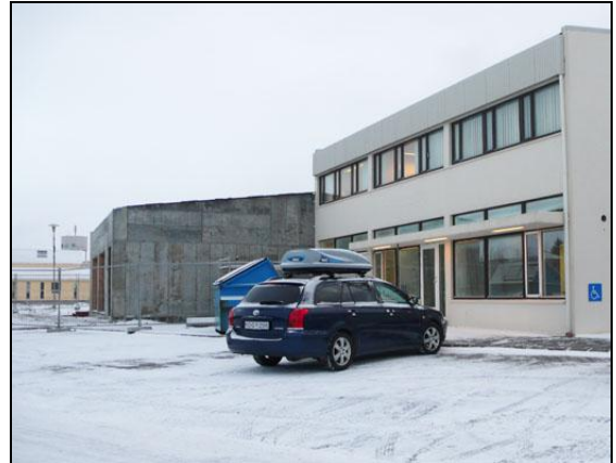
Eldri og nýrri hluti á byggingartíma.
