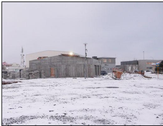
Uppsteypu nýbyggingarhluta lokið.
