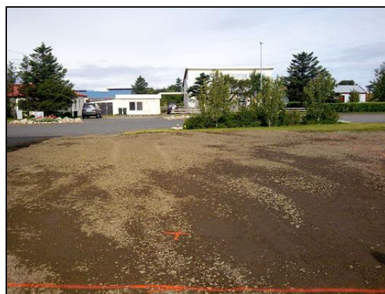
Farg var á byggingarreit við upphaf útboðsverks.
