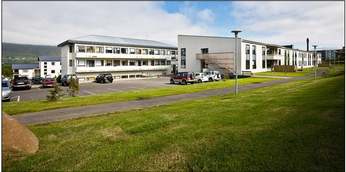
Tenging nýbyggingar við eldra hús tókst vel. Ljósmyndir CL.
