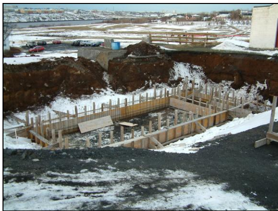
Uppsláttur kjallaraveggja að hefjast.
