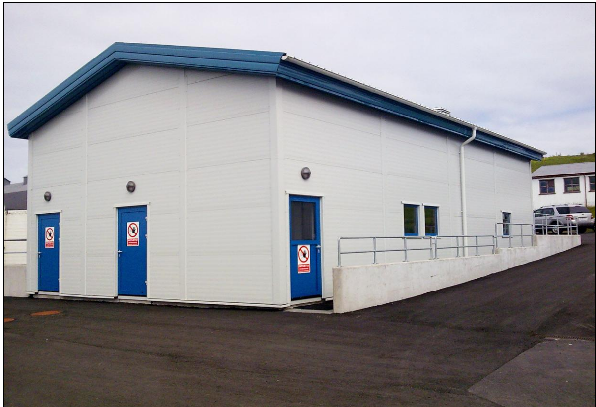
Fyrsti áfangi var uppsteypa kjallara og fullbúin yfirbygging
