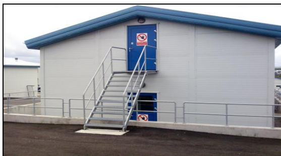
Norðurgafli og inngangur á tækniloftið.
