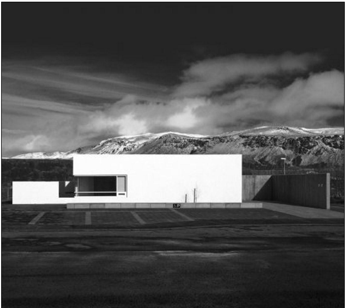
Sambýlishús Birkimörk 21 – 27, Hveragerði. Ljósmyndir PK-arkitekta.
