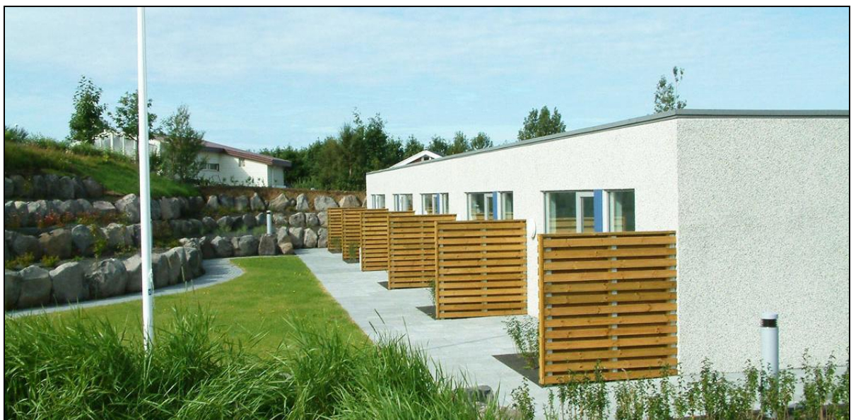
Baklóð sambýlisins við Bleikargróf 4.
