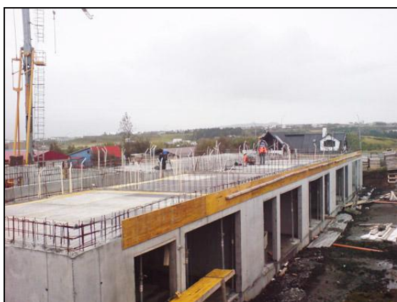
Unnið við uppsteypu.
