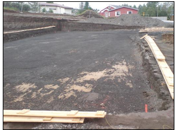
Fylling komin undir sökkla í júní 2008.
