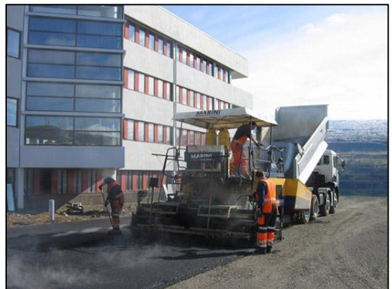
Unnið við malbikun bílastæðis, í mars 2005.
