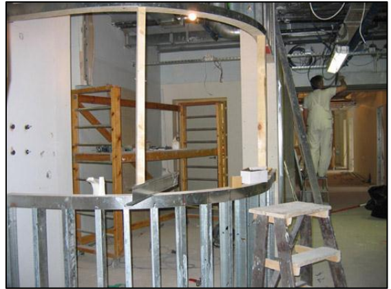
Unnið að smíði innréttinga, í apríl 2005.
