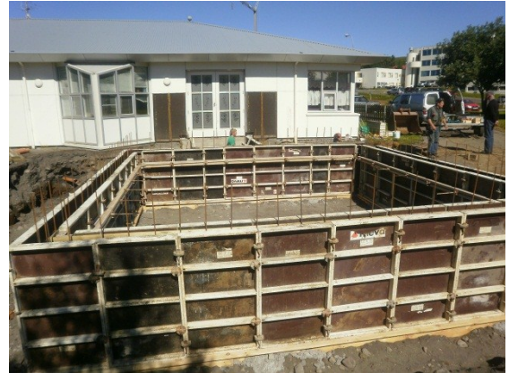
Mynd 2: Sökklar fyrir steypu
