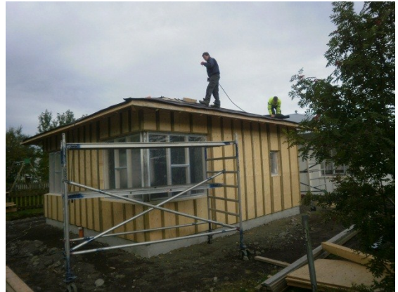
Mynd 9: Á framkvæmdatíma
