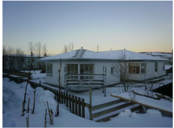
Mynd 1: Viðbyggingu að fullu lokið 17. desember 2010
