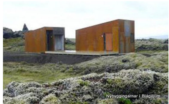
Mynd 10: Landvarðahúsin við lokaúttekt
