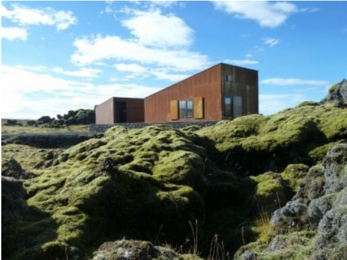
Mynd 11: Húsin falla vel að landslagi
