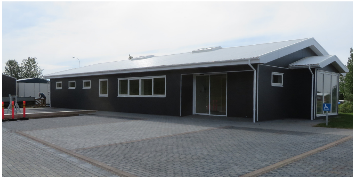
Mynd 1. Nýja heilsugæslustöðin í Mývatnssveit.
