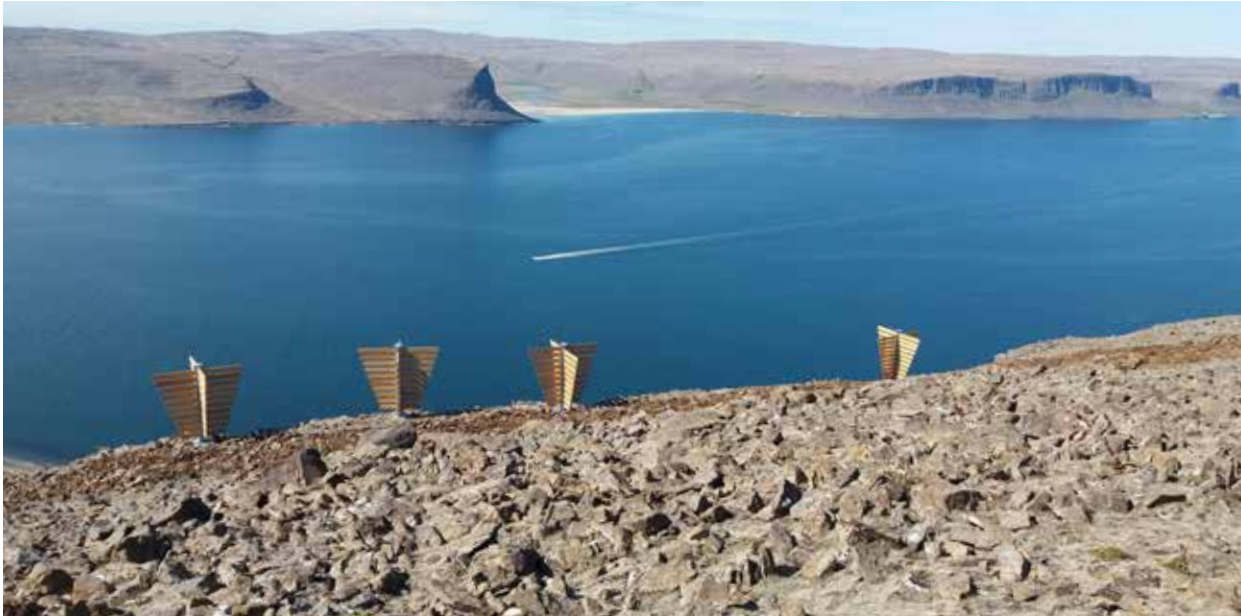
Mynd 1. Vindkljúfar ofan upptakasvæða Urða og Klifs á Patreksfirði. Þeim er ætlað að skapa vindsveipi svo snjóhengjurnar sem myndast í klettum undir vindkljúfunum verði ekki samfelldar.
