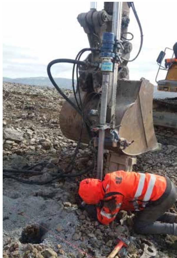
Mynd 9. Borað fyrir festingum undir snjósöfnunargrindur.
