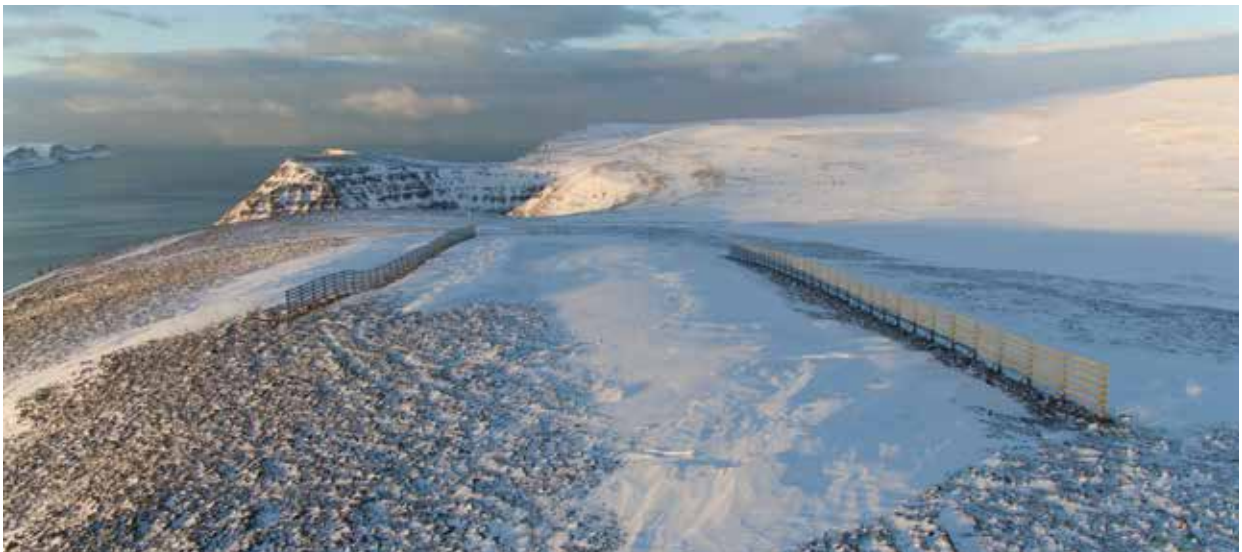
Mynd 11. Snjósöfnunargrindunum er ætlað er að hefta snjó uppi á fjalli áður en hann safnast í hengjur við klettana ofan við bæinn Patreksfjörð.
