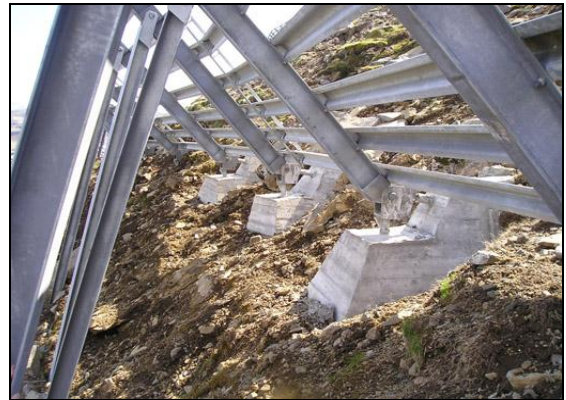
Steyptir voru klossar utan um festingar stálgrinda.
