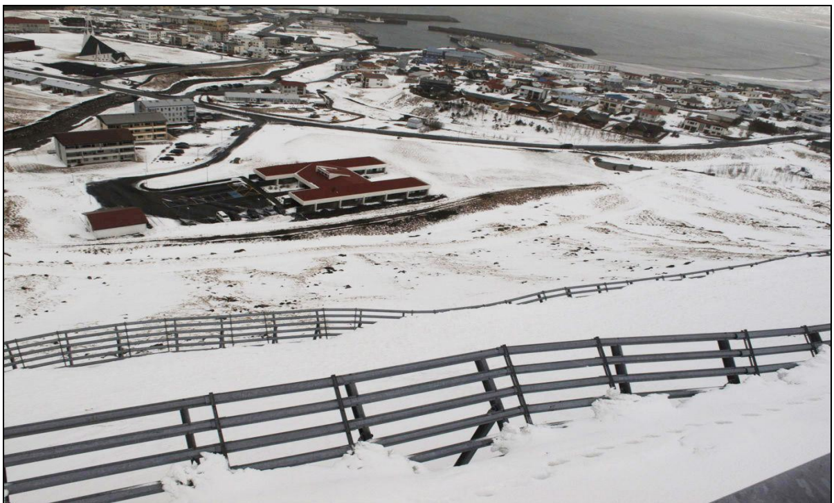
Snjór í stoðvirkjum eftir flóð í Tvísteinahlíð í mars 2012.
