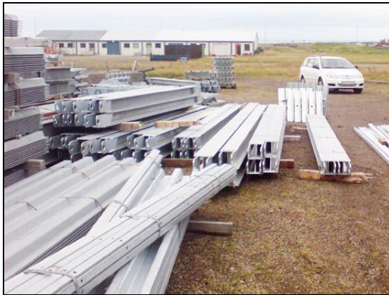
Efni í stoðvirki úr stálgrindum komin á lagersvæði.
