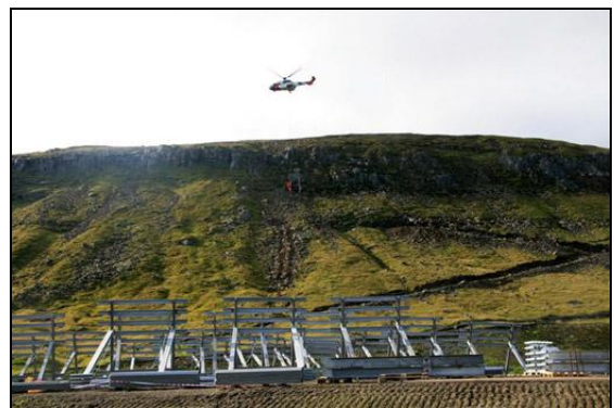
Þylran flýgur með fyrstu stálgrindurnar.
