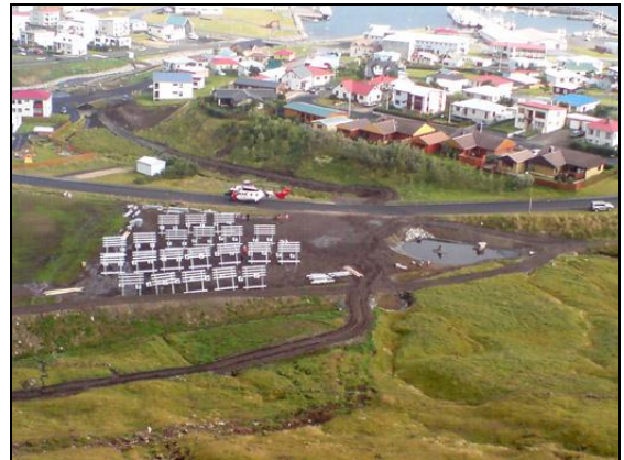
Samsettar stálgrindur tilbúnar fyrir hífingu.
