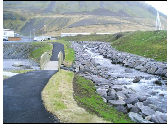
Frágangur við stíga og göngubrú við Bæjargilið.
